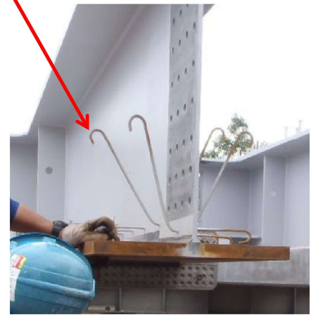
添接板取付時
