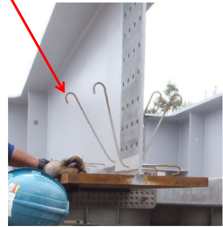
添接板取付時
