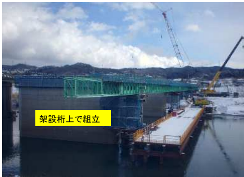
架設桁併用横取り架設(架設構台にクレーン設置)
