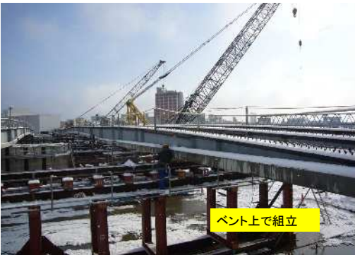
ベント併用横取り架設
