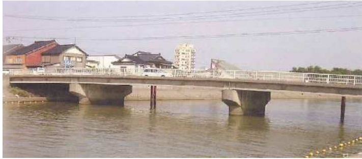
1973年（塩害対策 指針発行前）に施工された 日本海沿岸部塩害区分Sの橋梁
