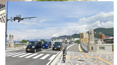
かみかわ ちの 上川橋(長野県茅野市) 2019年完工 3径間連続プレビーム合成桁 橋長 82.0m 幅員 16.550m 桁高 0.890～1.406m 桁高支間比 1/30～1/19
