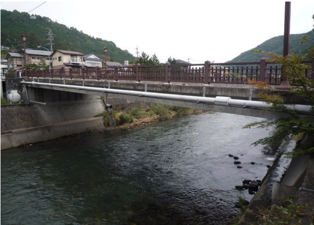
No.3 中央橋 ちゅうおう 1992年完工 長野県木曽郡木曽町福島上町（木曽川を跨ぐ橋） 場 所 概 要 桁 高 橋長37.0m、支間36.1m、幅員12.800m 1.000m、H/L=1/36
