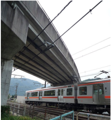
No.1 旭町跨線橋 あさひまちこせん 1986年完工 長野県木曽郡上松町（JR中央本線を跨ぐ橋） 場 所 概 要 桁 高 橋長21.4m、支間20.3m、幅員8.000m 0.700m、H/L=1/29
