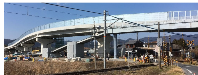
ゆい さち 結幸高架橋(滋賀県) 2016年完工 8径間連続プレビーム合成桁 橋長 258.5m 桁高 1.200m～1.600m 桁高支間比 1/27～1/20
