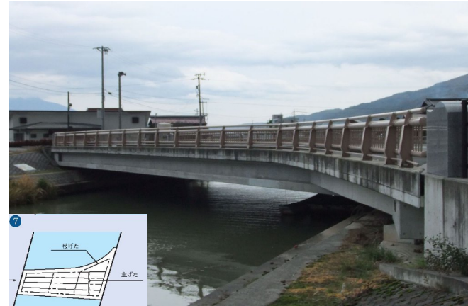
No.6 いしふなと しんかわ 石舟渡橋（新川橋） 2001年完工 場 所 長野県諏訪市豊田石舟渡（新川を跨ぐ橋） 概 要 橋長31,900mm、支間29,400mm、幅員17,600～29,700mm 構造高 120cm、H/L=1/24
