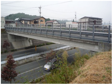
No.4 別府跨道橋 べっぷかどう 1999年完工 長野県飯田市上郷別府（飯田バイパスを跨ぐ橋） 場 所 概 要 桁 高 橋長35.0m、支間34.2m、幅員8,500mm 1.100m、H/L=1/31
