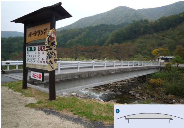
No.7 とぎわ 戸沢橋 ほんたに 2003年完工 場 所 長野県下伊那郡阿智村戸沢（本谷川を跨ぐ橋） 概 要 橋長34,000mm、支間33,100mm、幅員5,200mm 構造高 130～142.3cm、H/L=1/25～1/23
