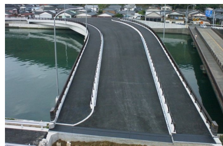
しんくろしま にちなん 新黒島橋(宮崎県日南市) 2003年完工 2径間連続プレビーム合成桁 橋長 107.0m 幅員 15.111～50.500m 桁高 1.550～2.700m 桁高支間比 1/34～1/19
