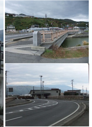
No.6 いしふなと しんかわ 石舟渡橋（新川橋） 2001年完工 場 所 長野県諏訪市豊田石舟渡（新川を跨ぐ橋） 概 要 橋長31,900mm、支間29,400mm、幅員17,600～29,700mm 構造高 120cm、H/L=1/24
