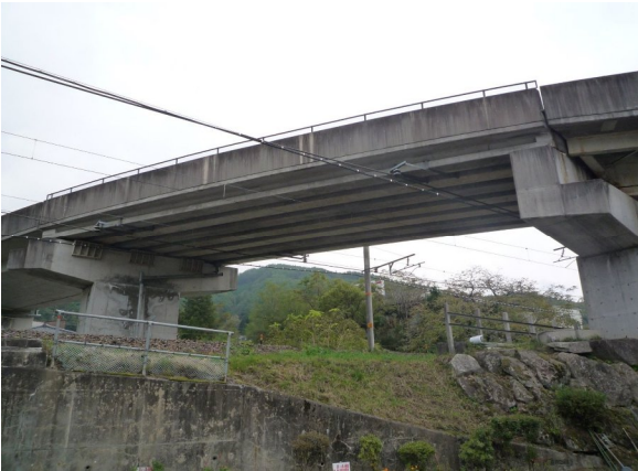
No.1 旭町跨線橋 あさひまちこせん 1986年完工 長野県木曽郡上松町（JR中央本線を跨ぐ橋） 場 所 概 要 桁 高 橋長21.4m、支間20.3m、幅員8.000m 0.700m、H/L=1/29
