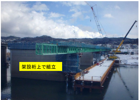
架設桁併用横取り架設（架設構台にクレーン設置）
