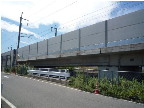
No.5 つきじ 築地BV（北陸新幹線） 1996年完工 場 所 長野県長野市篠ノ井築地 概 要 橋長22.0m、支間21.100m、軌道数2 構造高 1.300m、H/L=1/17
