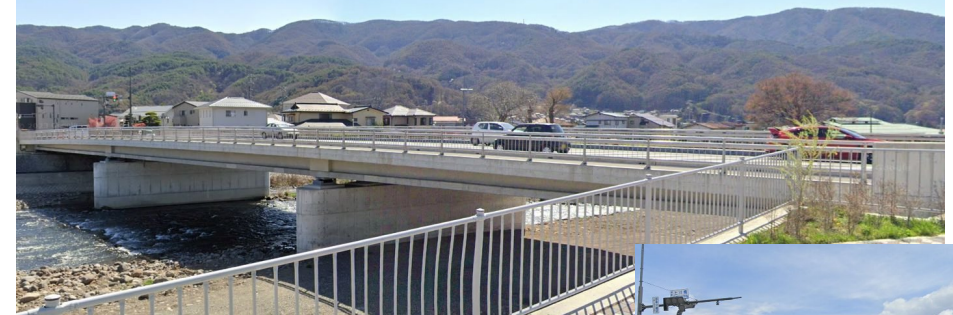
かみかわ ちの 上川橋(長野県茅野市) 2019年完工 3径間連続プレビーム合成桁 橋長 82.0m 幅員 16.550m 桁高 0.890～1.406m 桁高支間比 1/30～1/19
