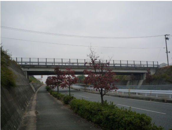
No.4 別府跨道橋 べっぷかどう 1999年完工 長野県飯田市上郷別府（飯田バイパスを跨ぐ橋） 場 所 概 要 桁 高 橋長35.0m、支間34.2m、幅員8,500mm 1.100m、H/L=1/31
