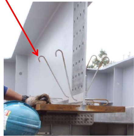
連結板取付時
