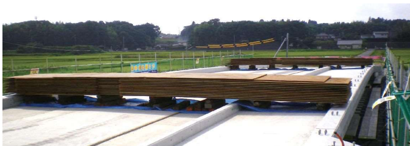
写真 敷鉄板を用いた局部プレストレスの施工例
