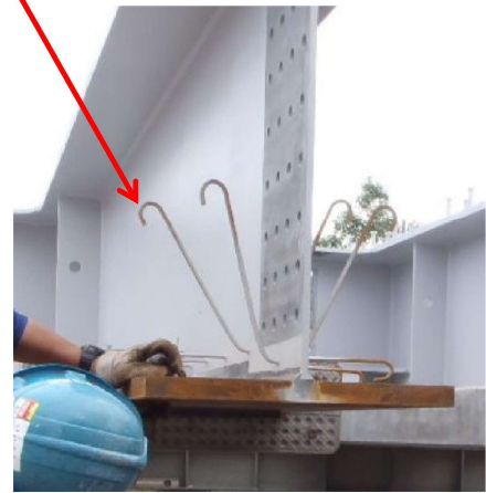
連結板取付時
