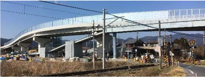
ゆいさち 結幸高架橋 (滋賀県甲賀市) 2016年完工 8径間連続プレビーム合成桁 橋長 258.5m 桁高 1.200m～1.600m 桁高支間比 1/27～1/20
