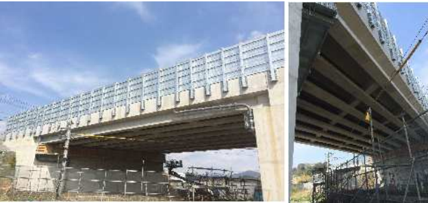
あるみ しんしろし 有海跨線橋 (愛知県新城市) 2013年完工 単純プレビーム合成桁 橋長 31.4m 桁高 1.400m 桁高支間比 1/22
