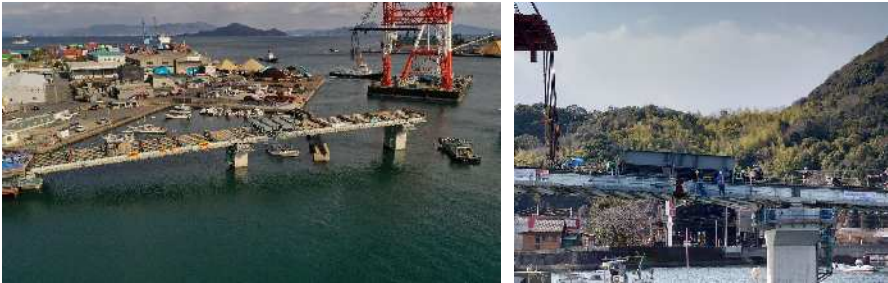
岩国臨港道路3号橋 (山口県岩国市) 2024年完工 4径間連続プレビーム合成桁 橋長 172.0m 桁高 1.400m 桁高支間比 1/30～1/31 ・FCによる一括架設 ・セッティングビーム使用 ・1期2期分割施工 ・ウェブコン省略/金属溶射
