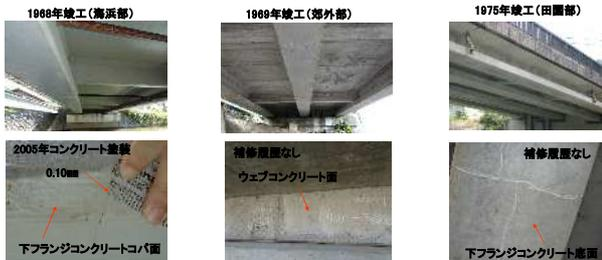
下フランジコンクリート、ウェブコンクリートに0.05~0.20mm程度のひび割れが発生
