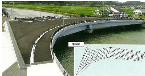
しんくろしま 新黒島橋 （宮崎県日南市） 2003年完工 2径間連続プレビーム合成桁 橋長 107.0m 幅員 15.111～50.500m 桁高 1.550～2.700m
