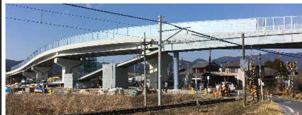
ゆいさち 結幸高架橋 （滋賀県甲賀市） 2016年完工 8径間連続プレビーム合成桁 橋長 258.5m 桁高 1.200m～1.600m
