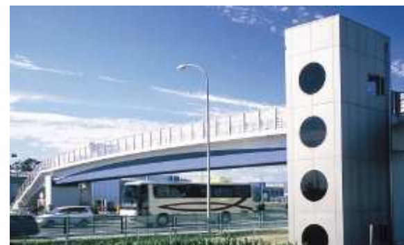
ラブリッジまっとう 日本道路公団北陸支社 発注 2002年完工 単純プレビーム合成桁 橋長 61.0m 桁高 2.200~2.550m
