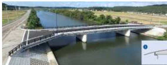
うわぎへいせい 上木平成大橋(石川県加賀市) 加賀市 発注 2015年完工 3径間連続プレビーム合成桁 橋長 75.600m 桁高 0.860~1.300m
